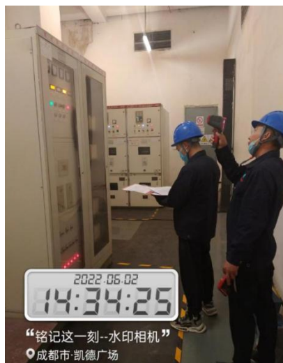
工作内容：对凯德广场进行配电柜运行工况检查和温度检测
