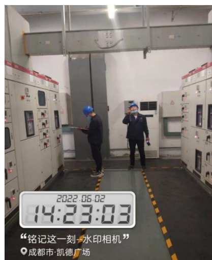
工作内容：对凯德广场进行配电柜运行工况检查和温度检测
