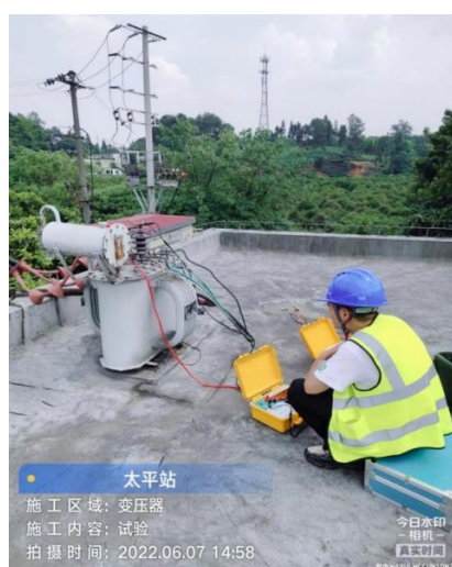
工作内容：对太平和成佳收费站进行变压器试验
