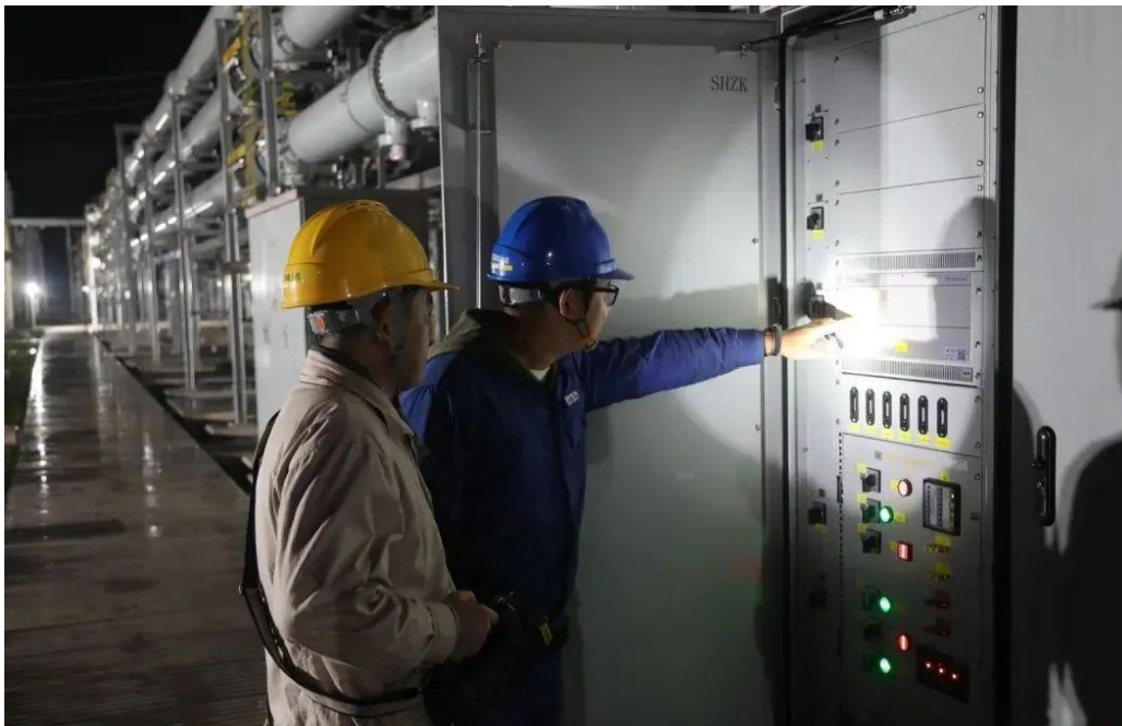
▲大林变电站投运调试现场
